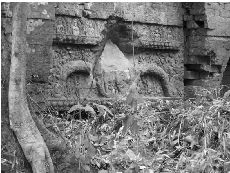
Trapeang Thnal Chukの破壊されたリントル
